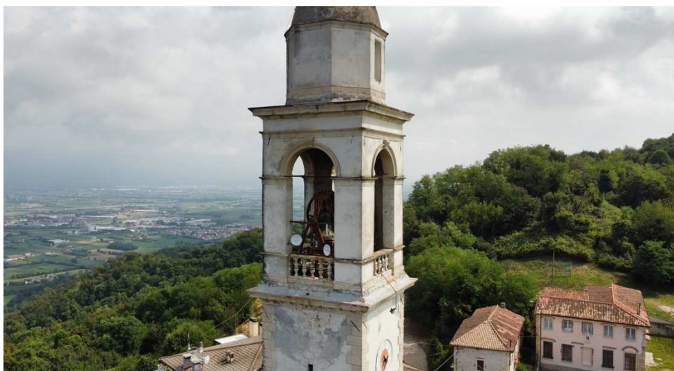
Foto 5 – visuale della cella campanaria.
