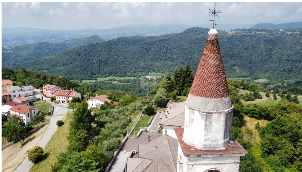
Foto 8 – particolare della cuspidale vista da sud-est – da notare l'evidente rifacimento degli ultimi 6 corsi e della macchia nera.
