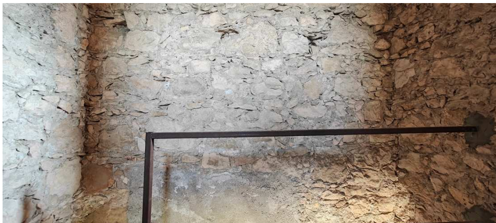
Foto 2 – dettaglio dell'apparecchio murario del fusto, primo impalcato lato Nord.
