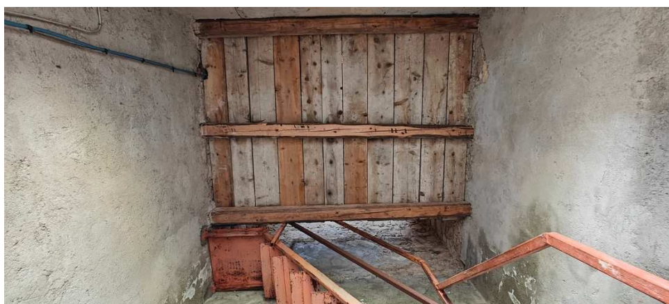
Foto 3 – dettaglio del solaio del primo impalcato.
