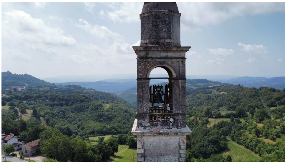
Foto 6 – visuale della cella campanara lato Nord – da notare in alto a sinistra il sistema costruttivo.
