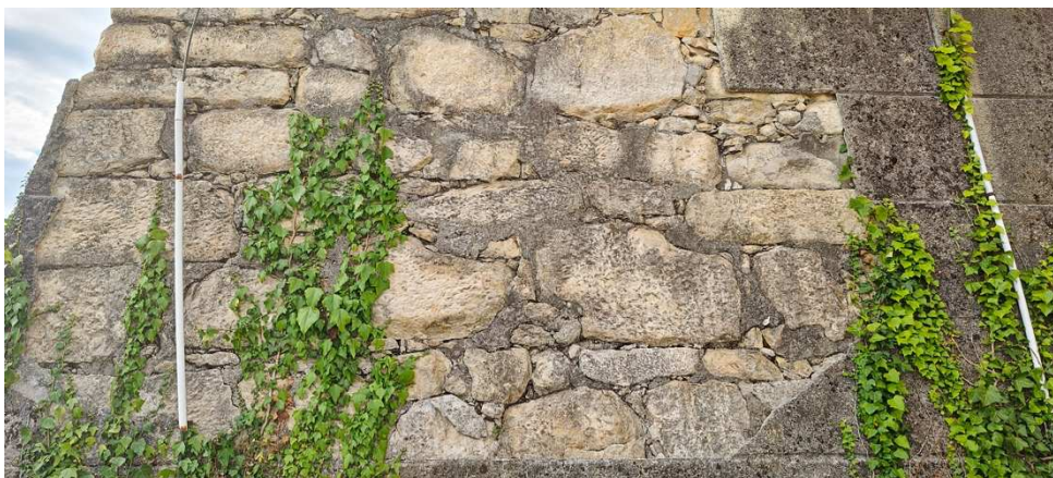
Foto 1 – dettaglio del basamento della torre, esterno lato Nord.
