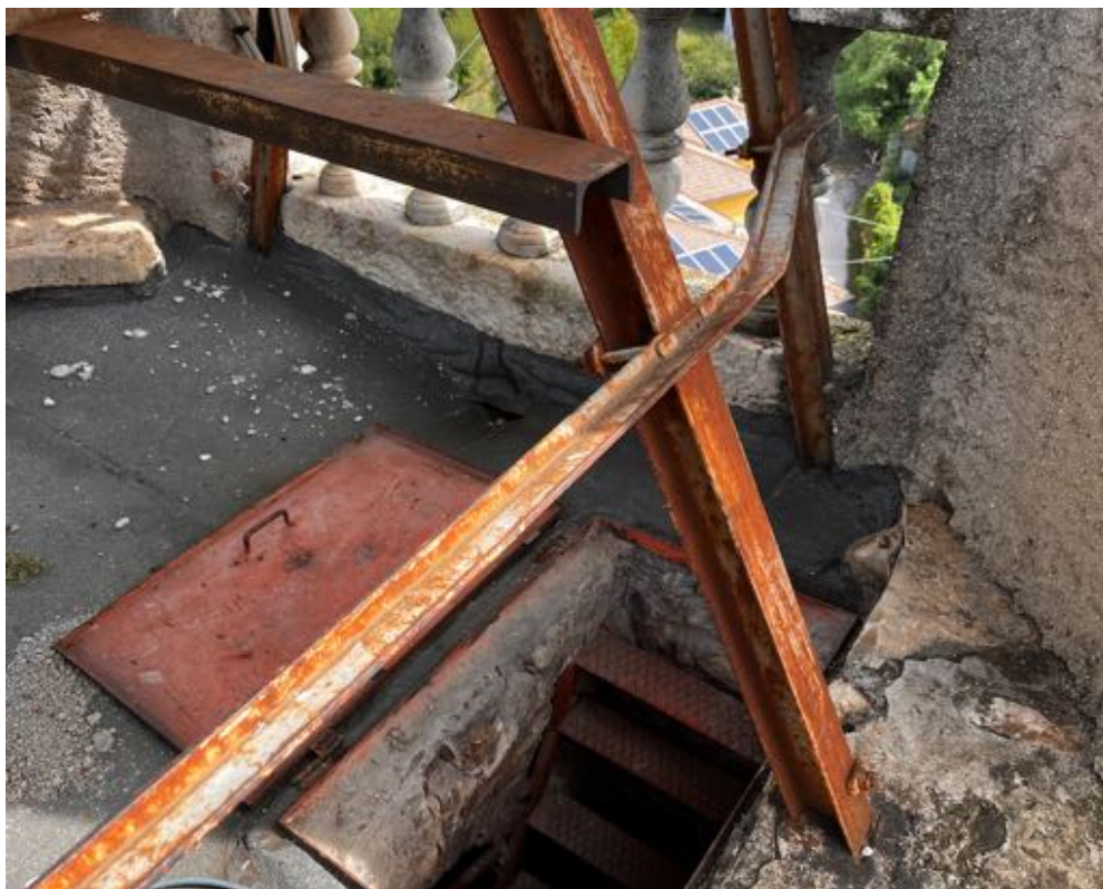
Capriate del telaio conficcate nel pavimento sulle basi affogate nel cemento
