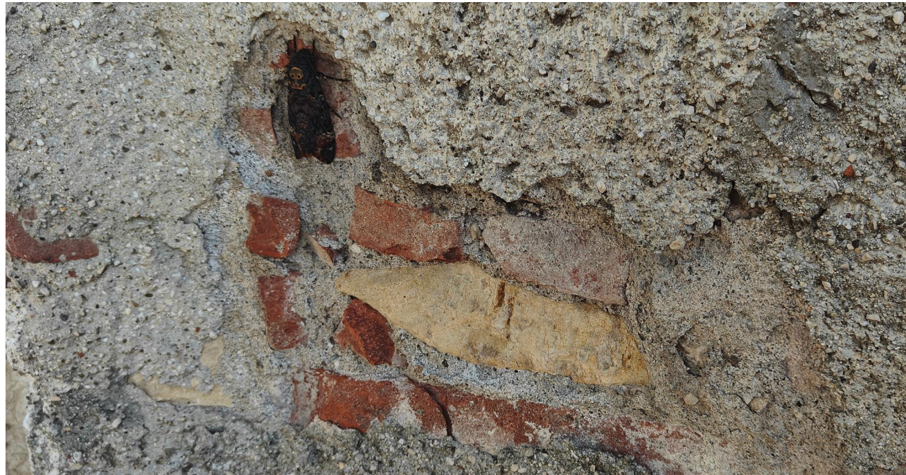
Vista 18 - particolare intonaco cella campanaria
