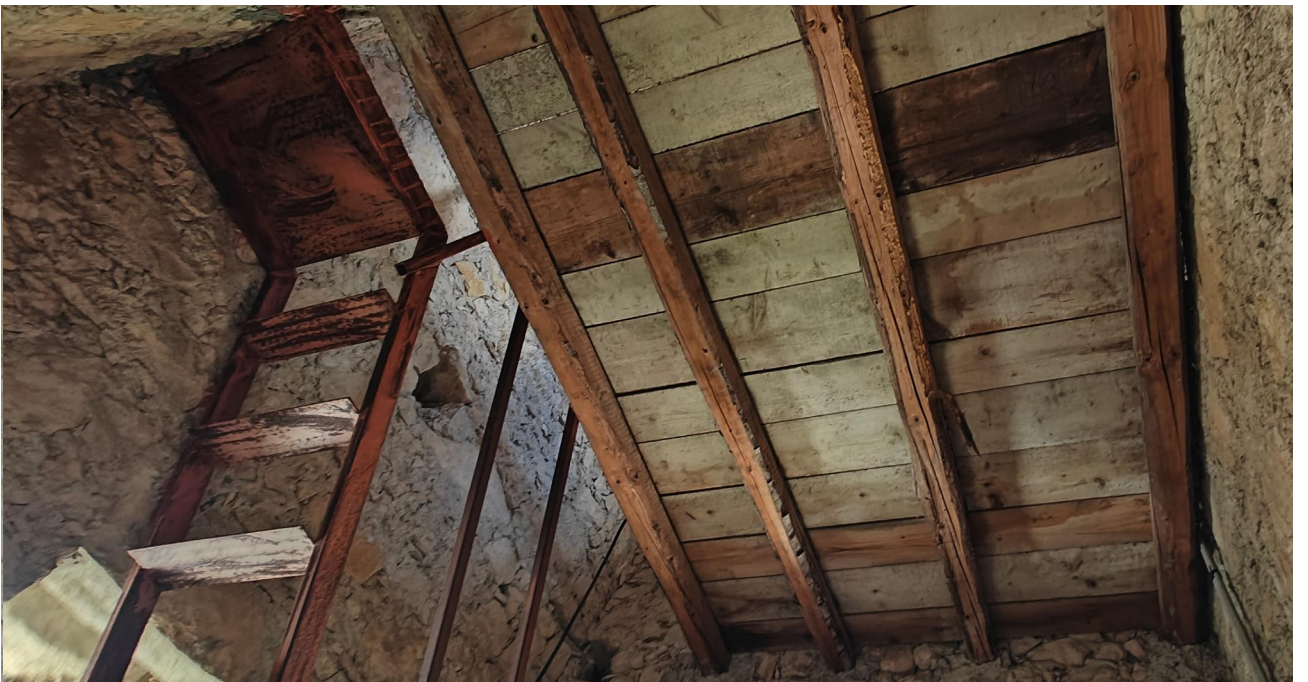
Vista 8 - secondo impalcato
