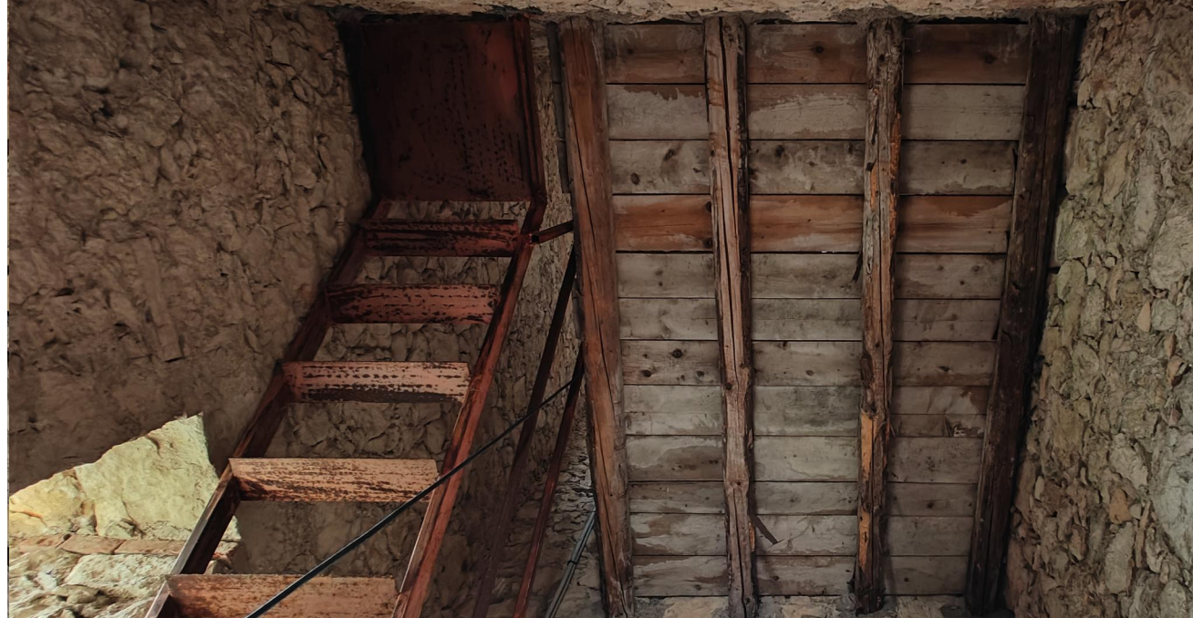
Vista 11 - terzo impalcato
