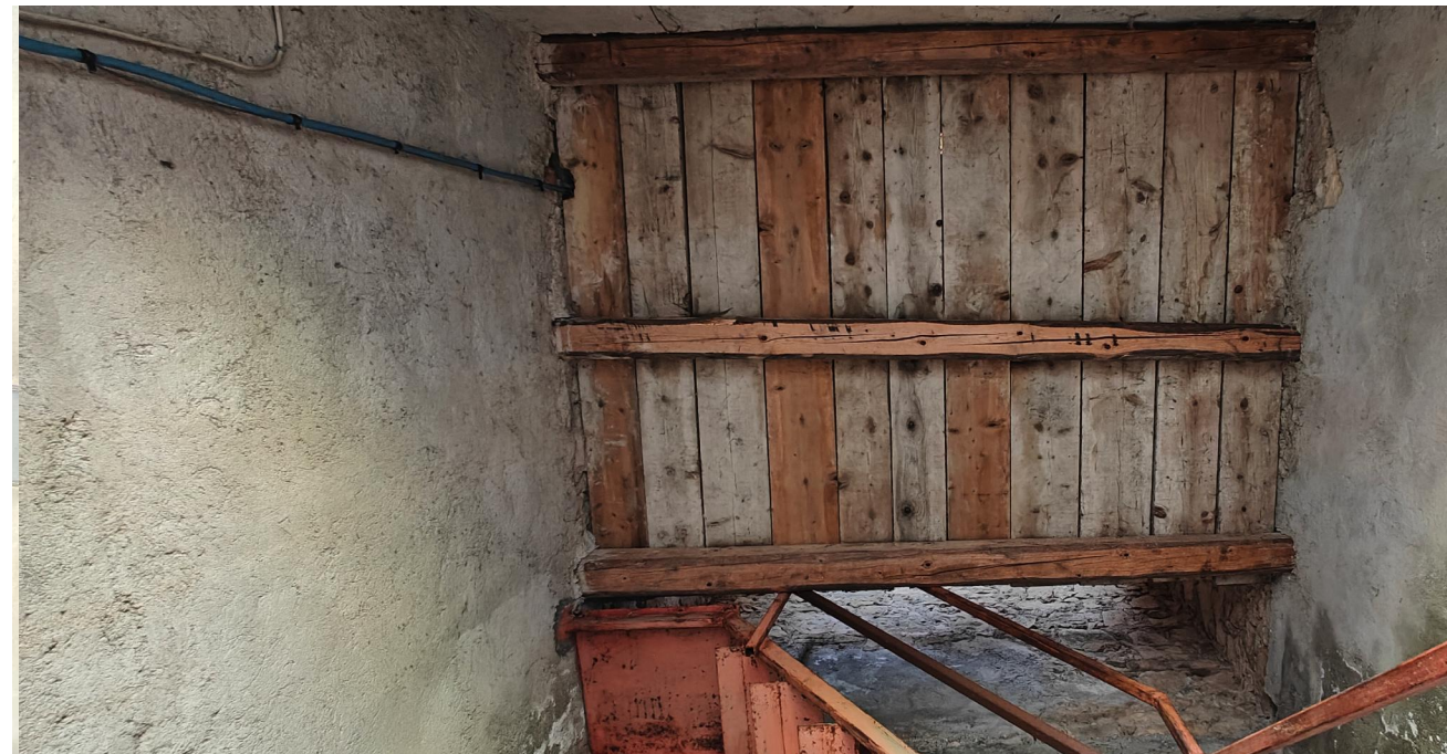
Vista 5 - primo impalcato
