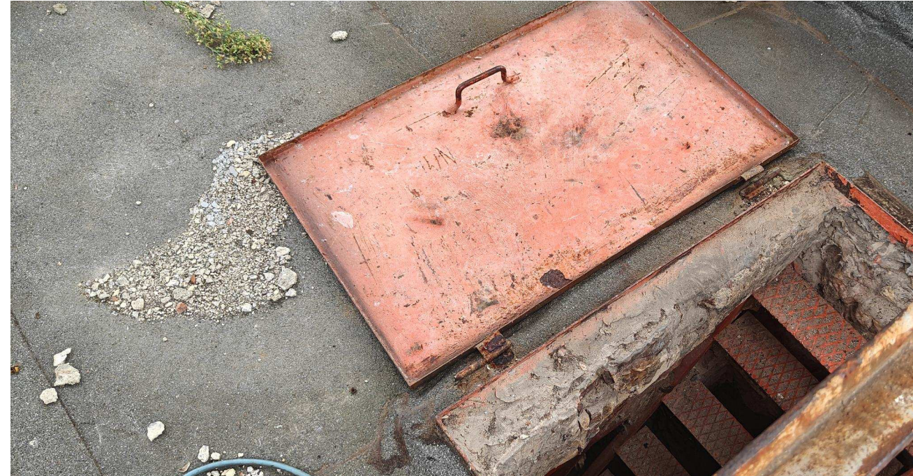
Vista 15 - pavimento cella campanaria e botola accesso
