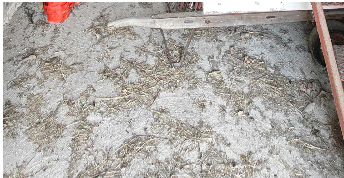
Vista 1 - pavimentazione piano terra
