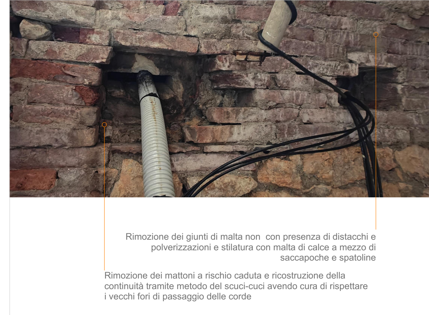
E - Ristilatura dei giunti e interventi di scuoi cucì nella volta
